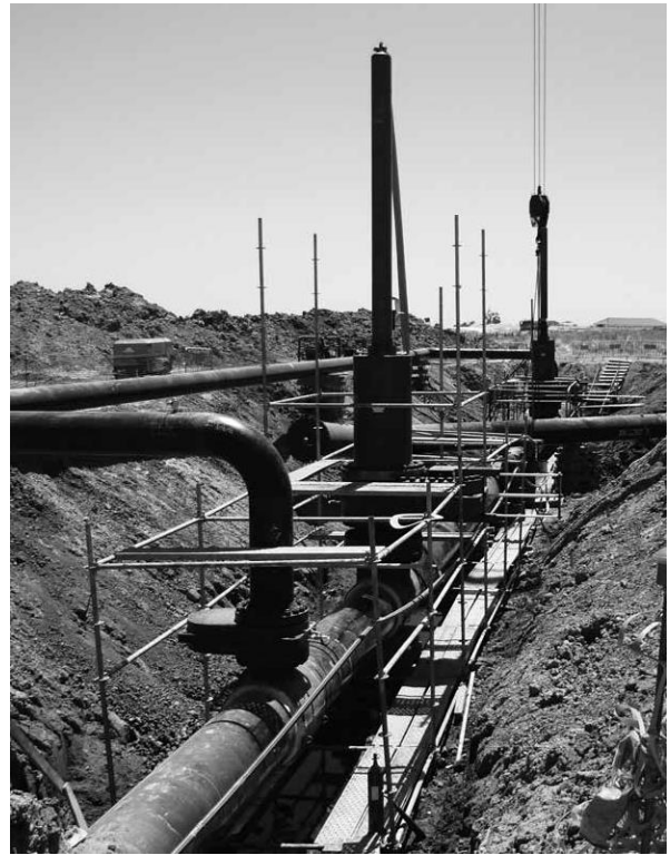
LineStop Operasyonu By-Pass Hattı ile Birlikte
