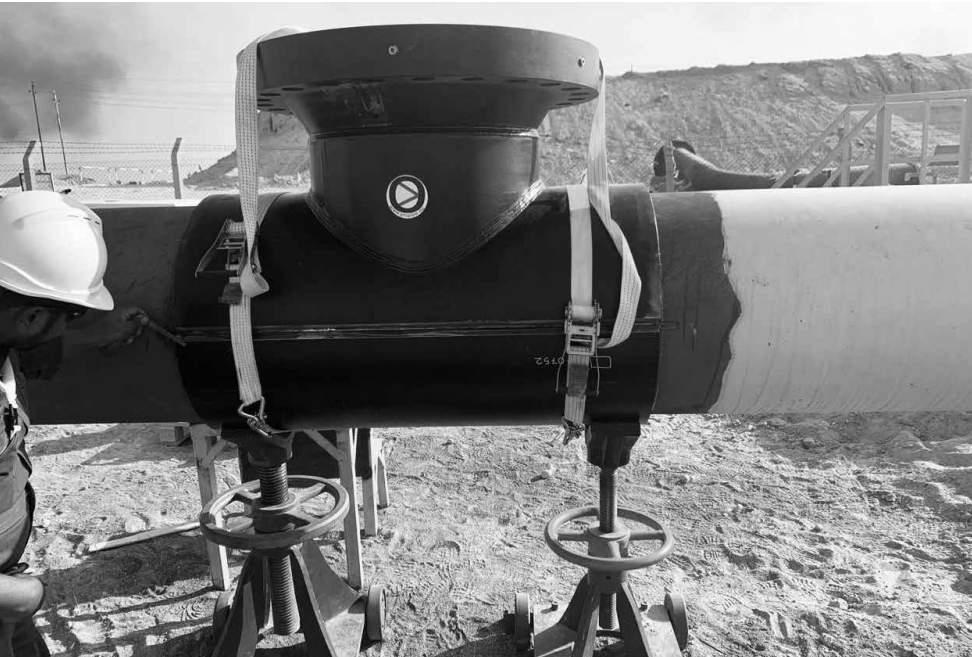
LineStop Fitting 600# RF 102 Bar Kaynak Operasyonu ( IRAK )
