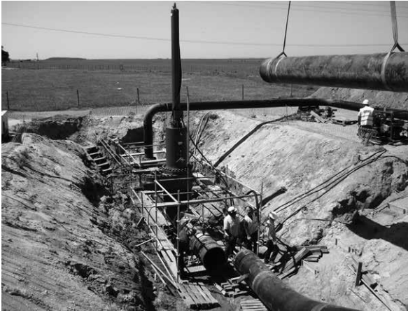
LineStop Operasyonu By-Pass Hattı ile Birlikte
